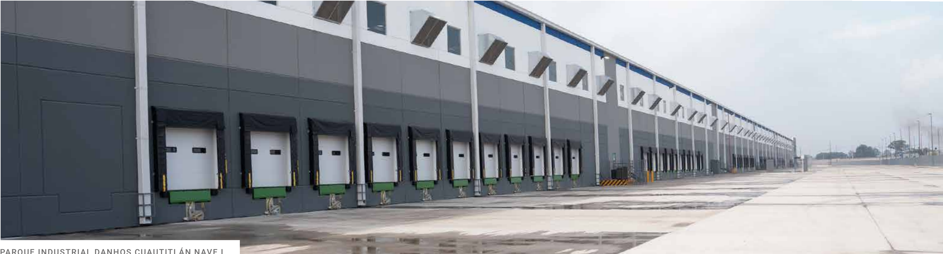
PARQUE INDUSTRIAL DANHOS CUAUTITLÁN NAVE I
