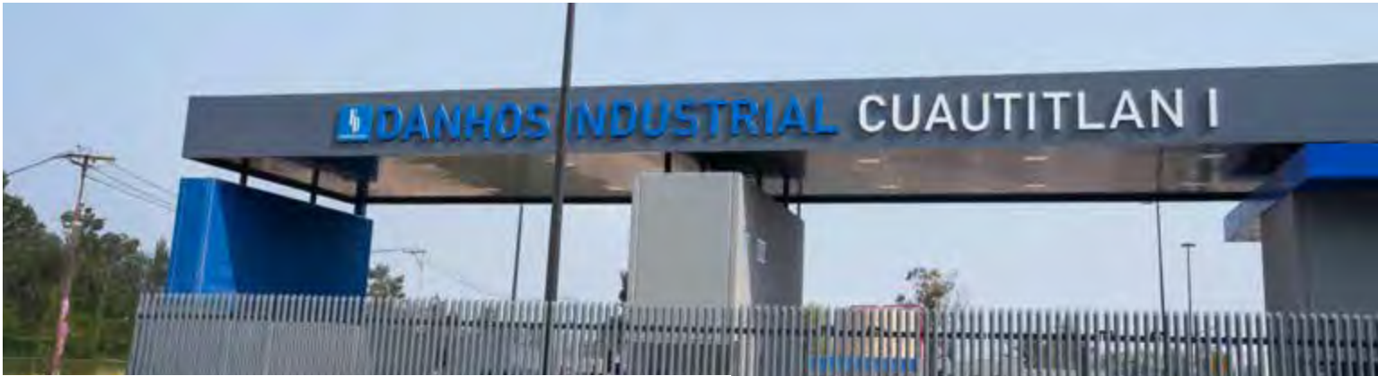
PARQUE INDUSTRIAL DANHOS CUAUTITLÁN NAVE I
